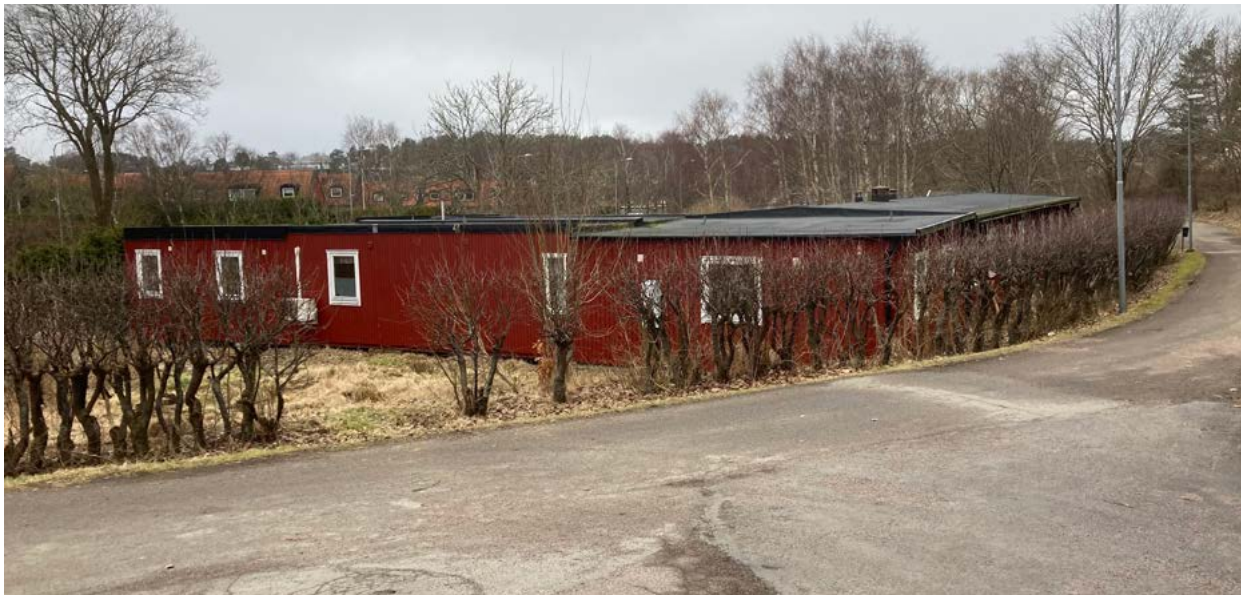
Byggnad uppförd som samlingslokal, senare ombyggd för annan verksamhet. Byggnaden står vid den gamla byvägen, vid oxelhäcken (med i bild i framkant).
