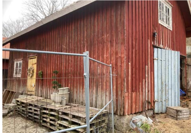
Troligtvis ursprungligen vagnslider och förrådsbyggnad, uppförd kring sekelskiftet 1900.
