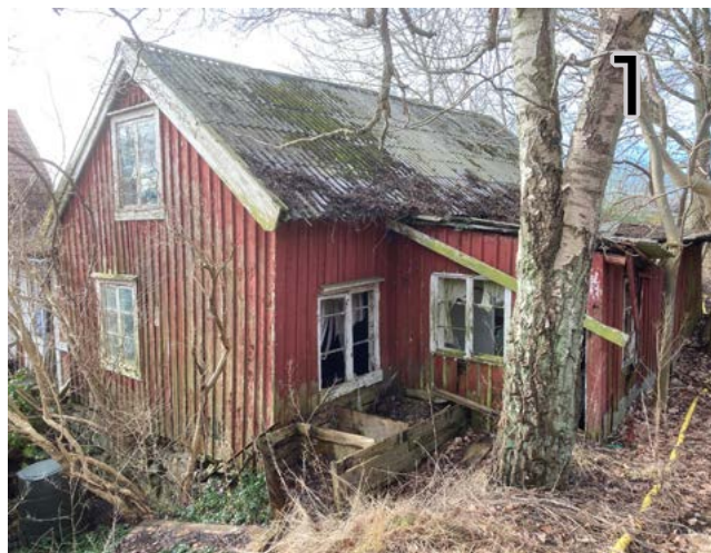
Äldre bostadshus, nordöstra fasaden.
